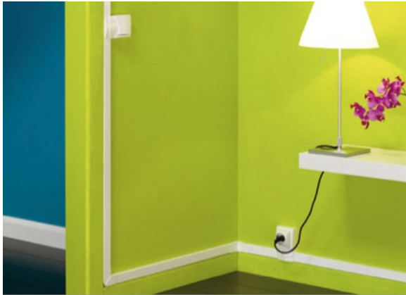
exemple d'installation en goulotte
